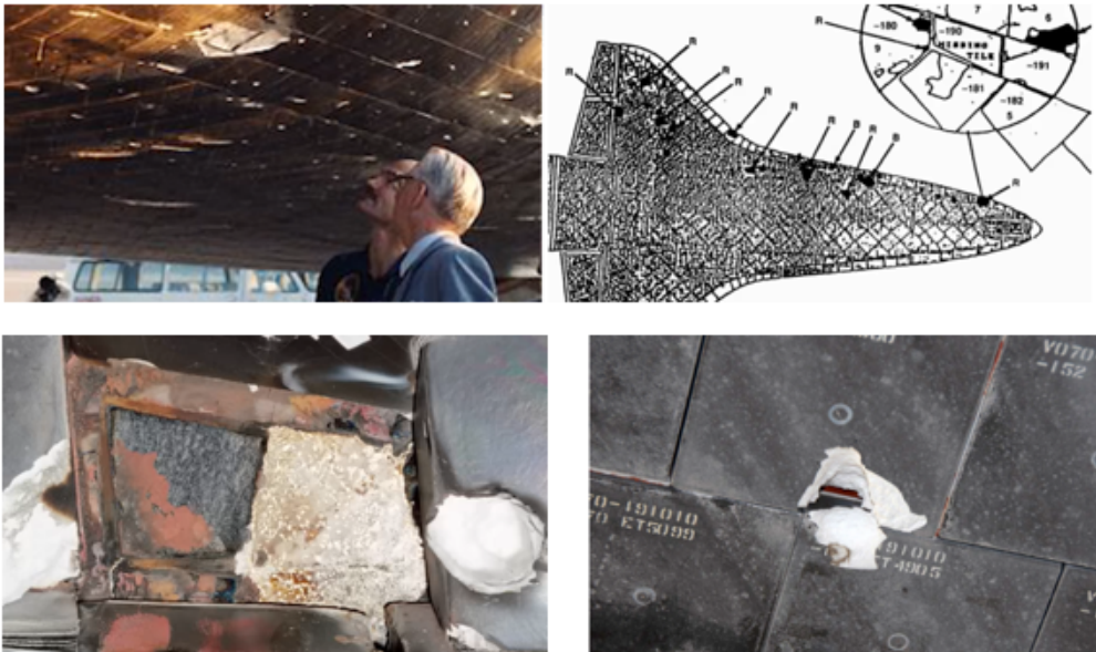
Fig. 47b – Danos na proteção térmica (de tijolos cerâmicos) da missão STS-27, EM 1988 (15 anos antes do acidente do Columbia)
